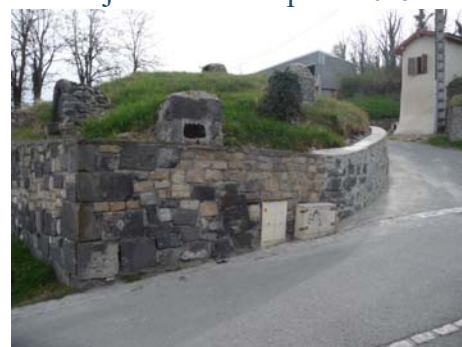
Travaux réalisés en 2019
