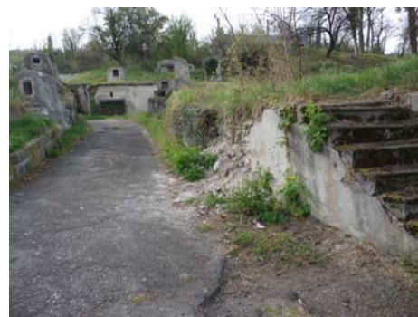
Projet de travaux pour 2019
