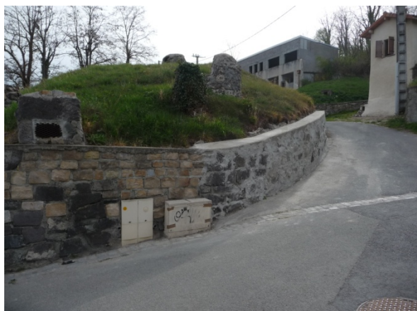
Le mur après la reconstruction
